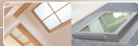
天井から自然光を取り込む天窗
